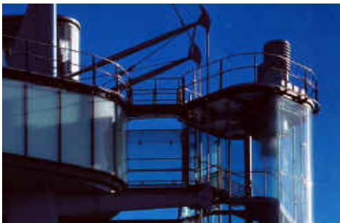
Figura 12: detalhe escada observatório
