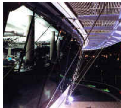
figura 09: detalhe dos vidros
