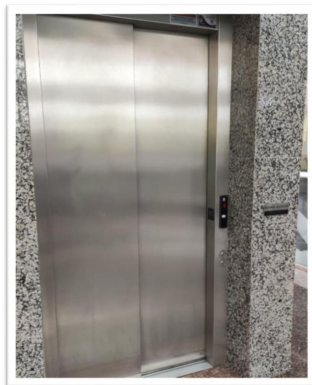
Imagem 8: Elevadores em todos os blocos
