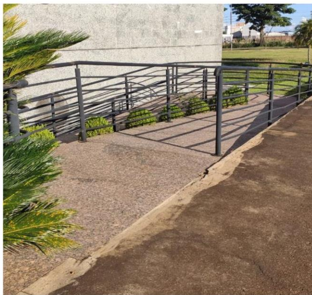
Imagem 3: Rampa de acesso à Reitoria - pelo estacionamento.
