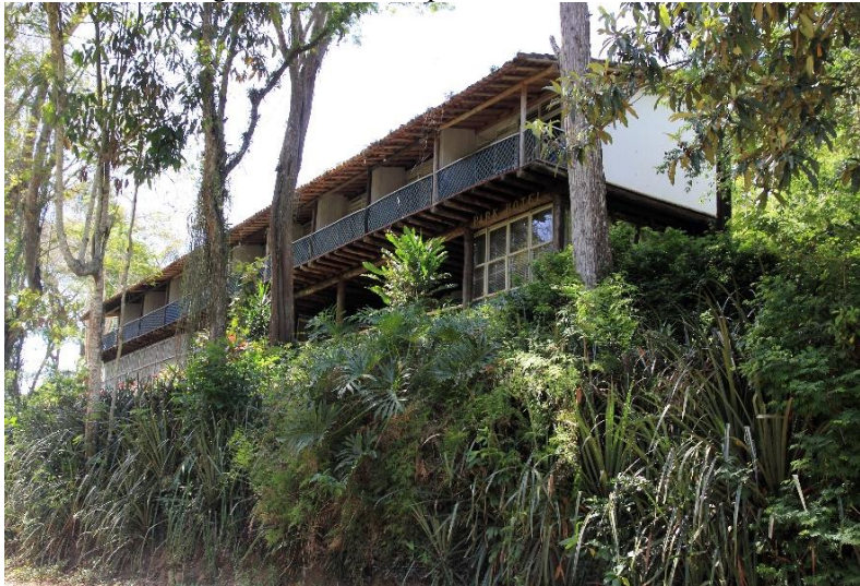
Figura 08: Visão da parte externa do Hotel
