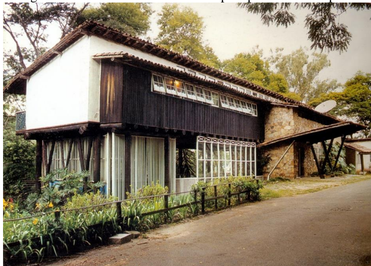
Figura 03: Barra de madeira interrompida por volume de pedra
