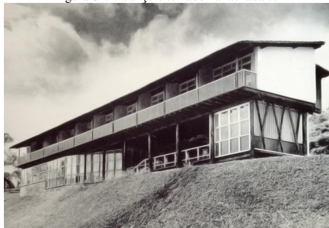
Figura 02: Balanço e telhado na fachada sul
