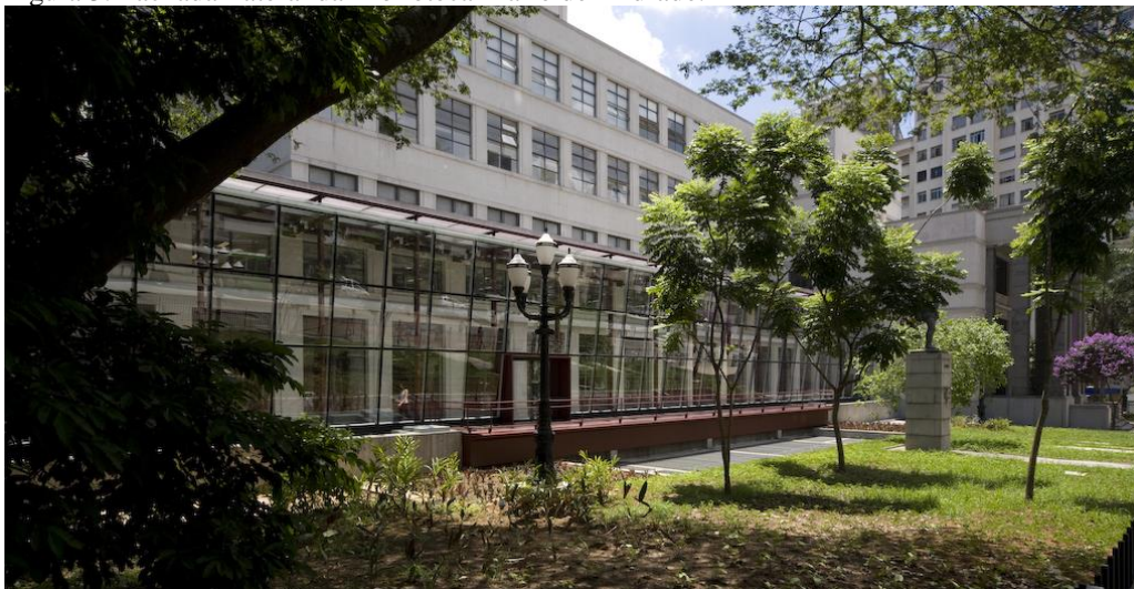
Figura 3: Fachada Lateral da Biblioteca Mario de Andrade.
