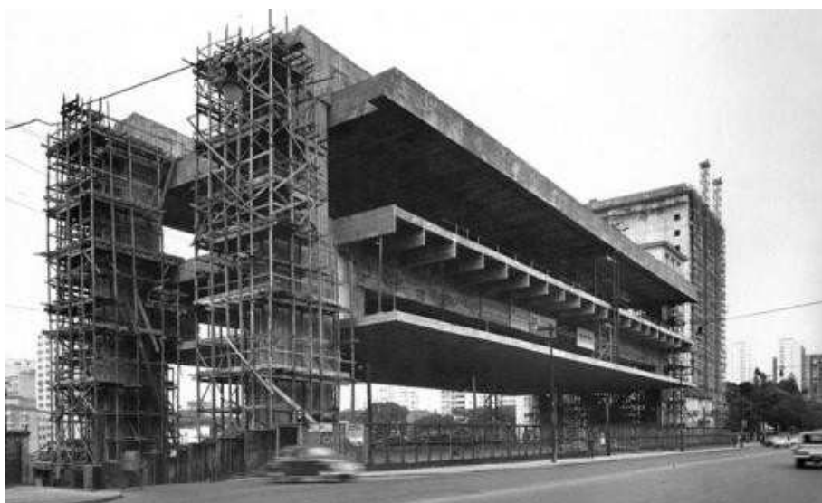
Figura 06 – Construção do MASP
