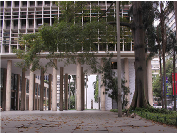
Figura 01: Pilotis com 10 metros de altura.
