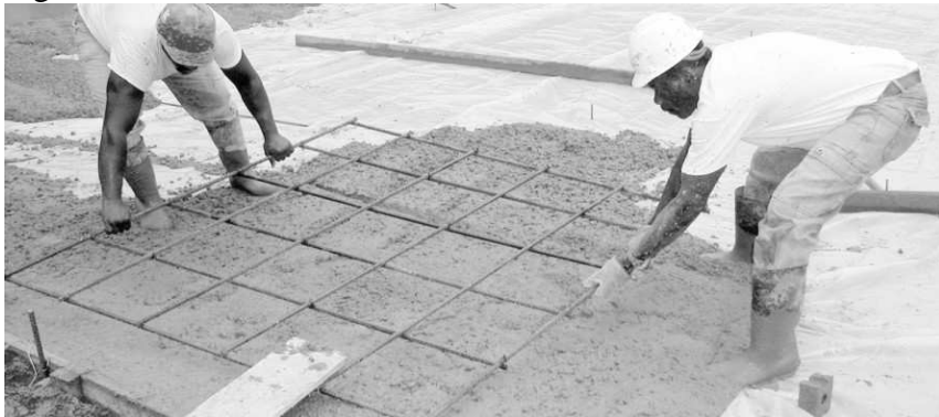
Figura 02: Armadura metálica e concreto
