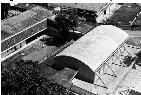
Figura 05 - Ginásio do complexo Pedregulho.
