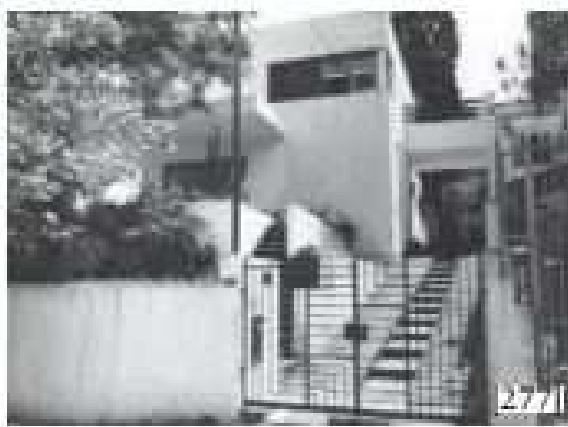
Figura 06 – Vista Frontal da Casa da rua Itápolis.
