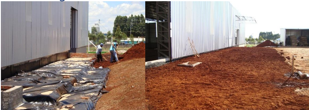
Figura 11- Nivelamento no solo com EPS
