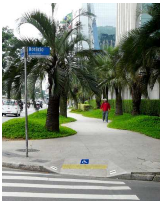
Figura 7 – Rebaixamento de guia para usuários com necessidade especial.
