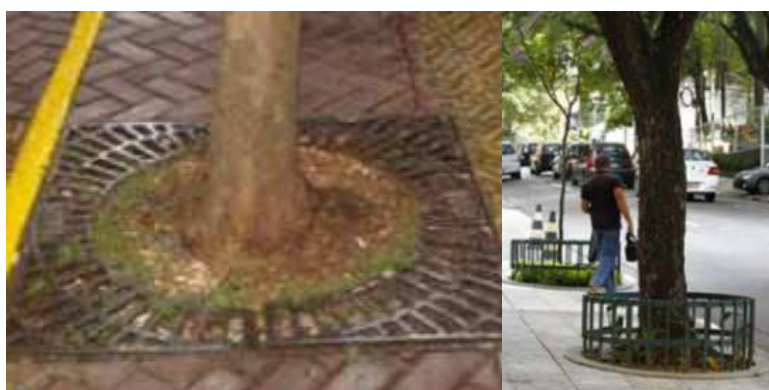
Figura 08 e 09 – Grelha e gradil para árvores no calçamento.
