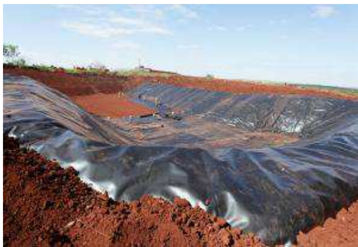
Figura 3 – Área do aterro sanitário preparada para receber os resíduos.
