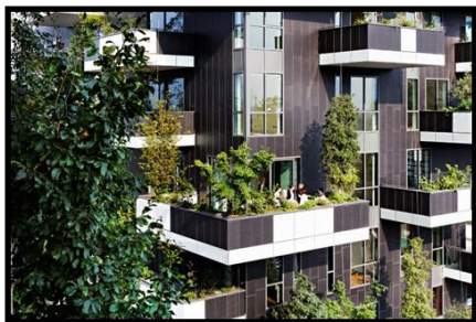
Figura 08 - Terraços Verdes do Edifício
