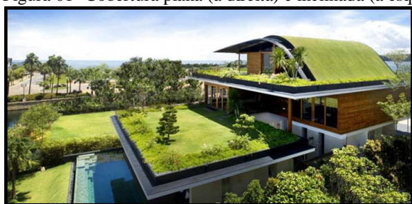
Figura 01- Cobertura plana (à direita) e inclinada (a esquerda) em uma mesma edificação.
