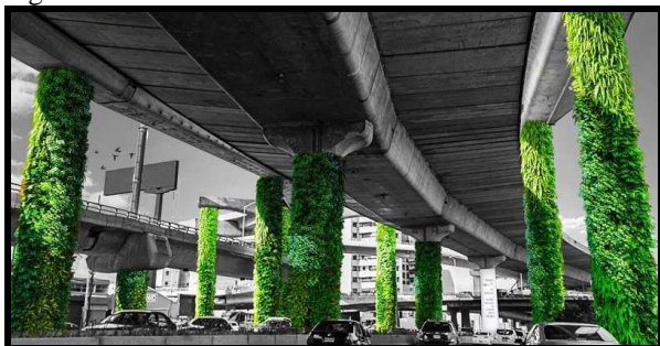
Figura 10 – Viaduto Verde na Cidade do México
