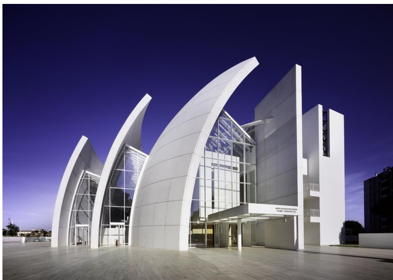
FIGURA 5: Vista frontal da obra.
