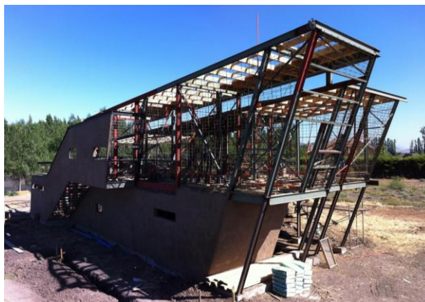
Figura 4: Estrutura e malha metálica.
