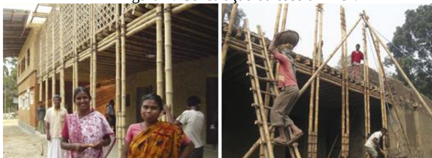
Figura 1: Construção da escola DESI.
