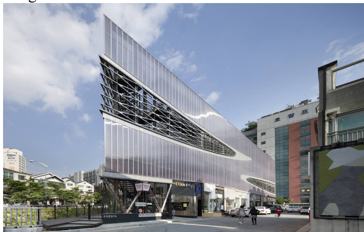
Imagem 4 – Edifício de Estacionamento Herma – Vista Frontal
