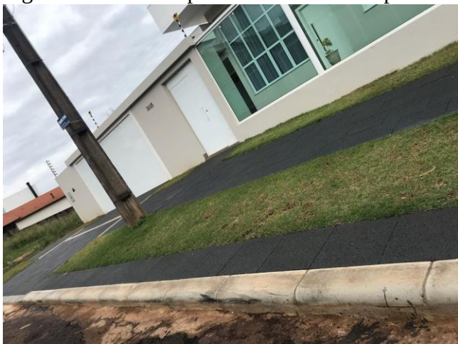
Figura 01 – Passeio público realizado em pavimento drenante.
