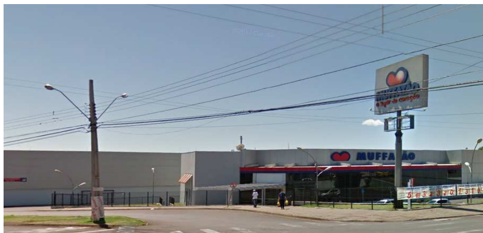
Figura 13: Posteamento novo e antigo no Muffatão do bairro – Rua Carlos B. Cancelli
