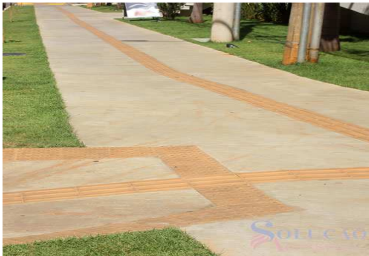
Figura 03: Calçada com piso tátil e rampa de acesso em boas condições
