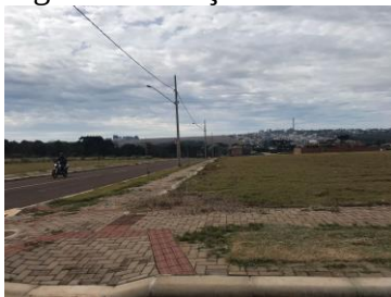
Figura 04: Calçada com tamanho mínimo.
