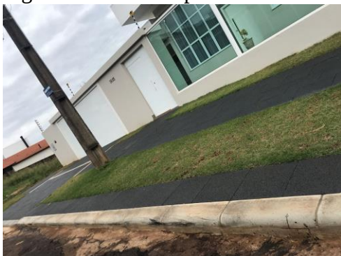
Figura 01 – Passeio público realizado em pavimento drenante.
