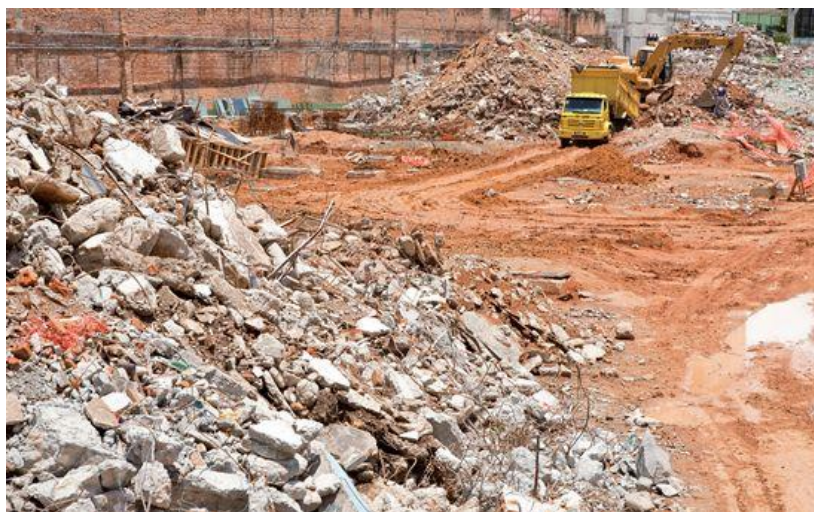
IMAGEM 1- Canteiro de obra com entulho.
