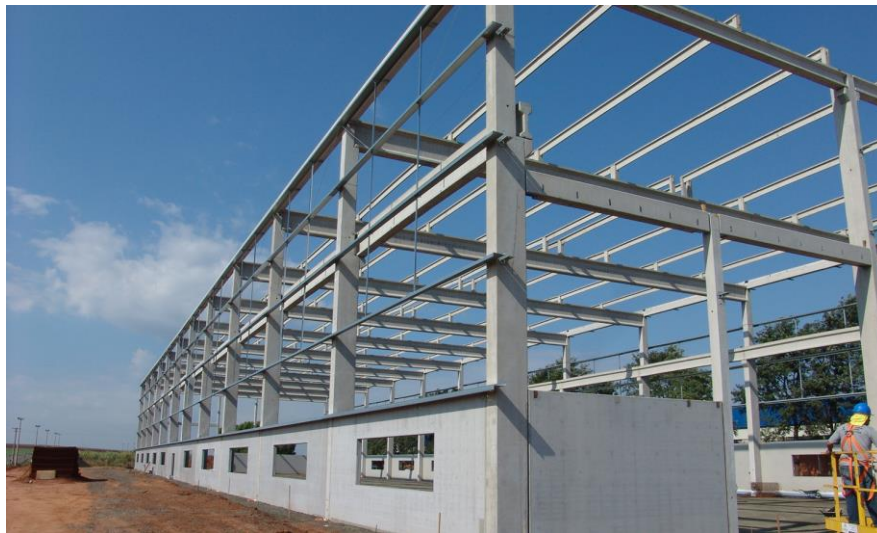
IMAGEM 2- estrutura de pré-fabricado.
