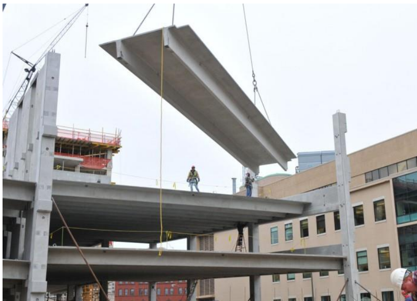
IMAGEM 4- Encaixe de uma placa de pré-fabricado.
