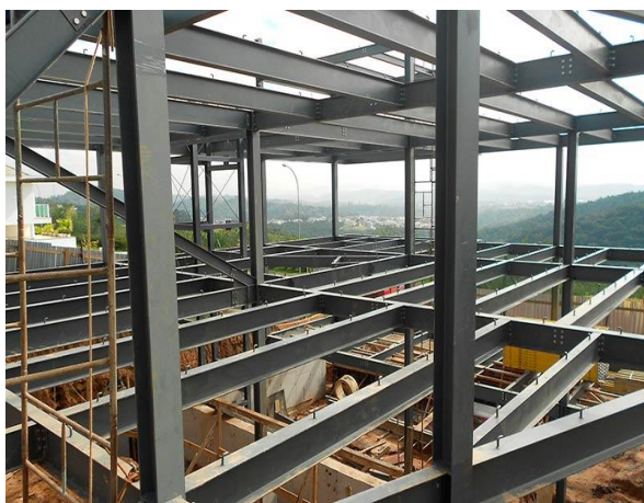
Imagem 01 – Utilização do aço na construção
