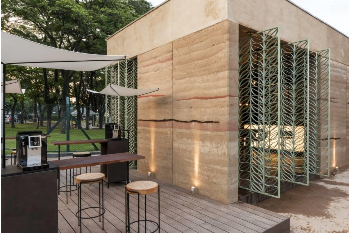
IMAGEM 04. O Café Experiência da CASACOR São Paulo 2017 se destaca por suas paredes feitas de taipa de pilão. Fonte: (DRUMOND, 2017).
