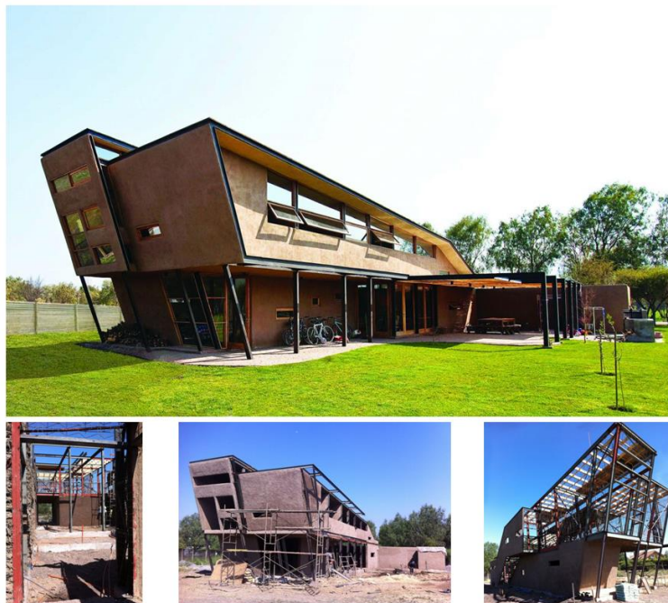
IMAGEM 02 – Fotografias da Casa Munita durante a obra e ela já pronta, onde mostra que ao invés do bambu foi utilizado a ferro para construir o quadro e depois feito barreamento. Fonte: SURTIERRA ARQUITECTURA
