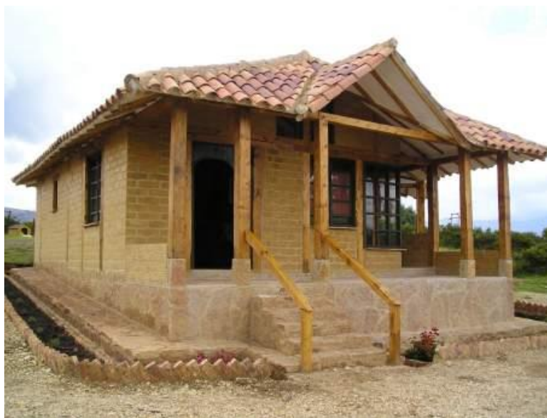
IMAGEM 05. Mostra uma obra feita de tijolo adobe. Fonte: (MUSEU DE CACULÉ, 2016).
