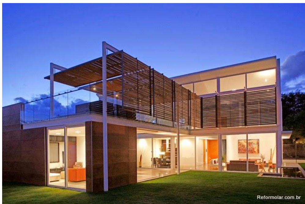
Figura 1 e 2. Construção em Steel Framing
