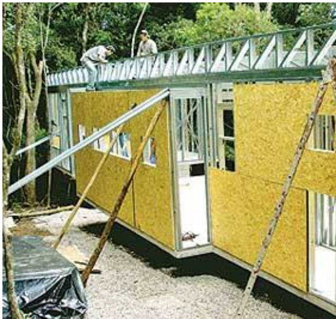
Revestimento do Steel Frame
