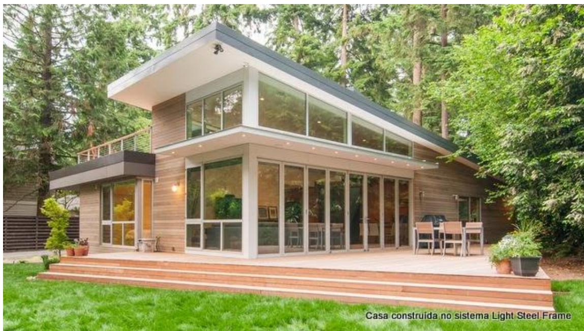
Figura 3. Casa Construída com o sistema LDF
