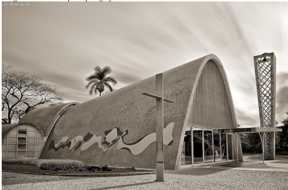
Imagem 02. Fachada principal Igreja São Francisco de Assis.
