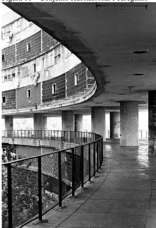
Figura 01 – Conjunto Habitacional Pedregulho
