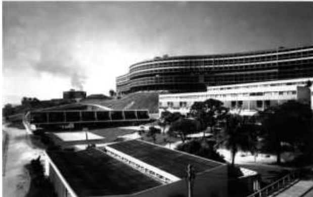
Figura 03 – Conjunto Habitacional Pedregulho
