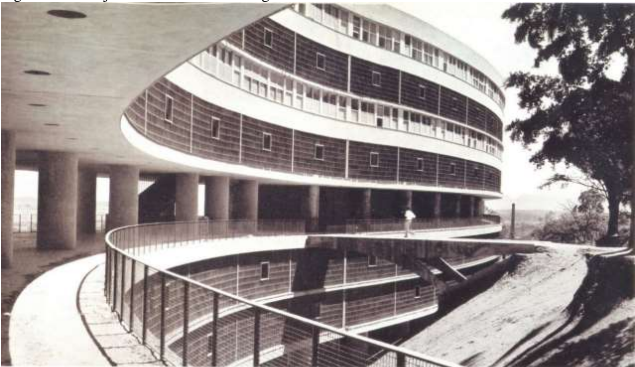
Figura 02 – Conjunto Habitacional Pedregulho
