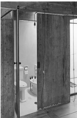
FIGURA 05: Interior da Residência Butantã, detalhe do banheiro em concreto.
