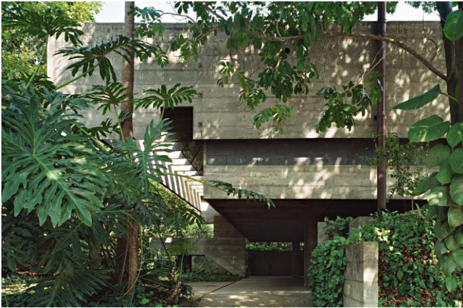
FIGURA 04: Residência Butantã com talude elevado.
