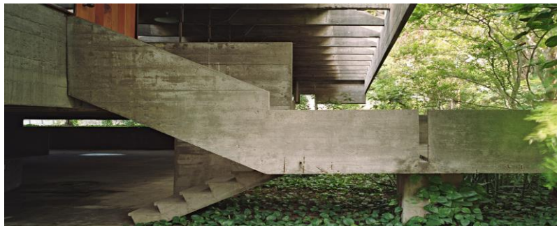
FIGURA 07: Fachada externa e pavimento elevado.
