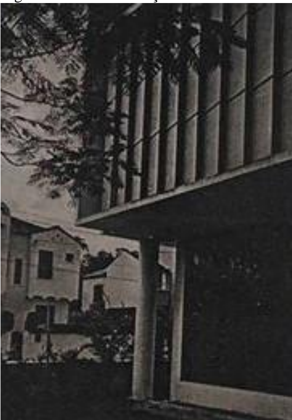
Figura 02: Obra do Berço.
