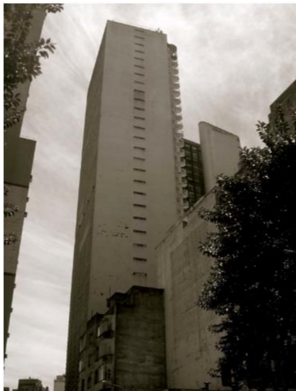
Figura 14 – Fachada Oeste edifício Copan. (Fonte: teses.usp.br/teses/disponiveis/16/16138 )
