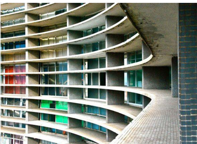
Figura 12- Fachada com brise soleil edifício Copan. (Fonte: luizabaldan.com/indice--mam-rio/)
