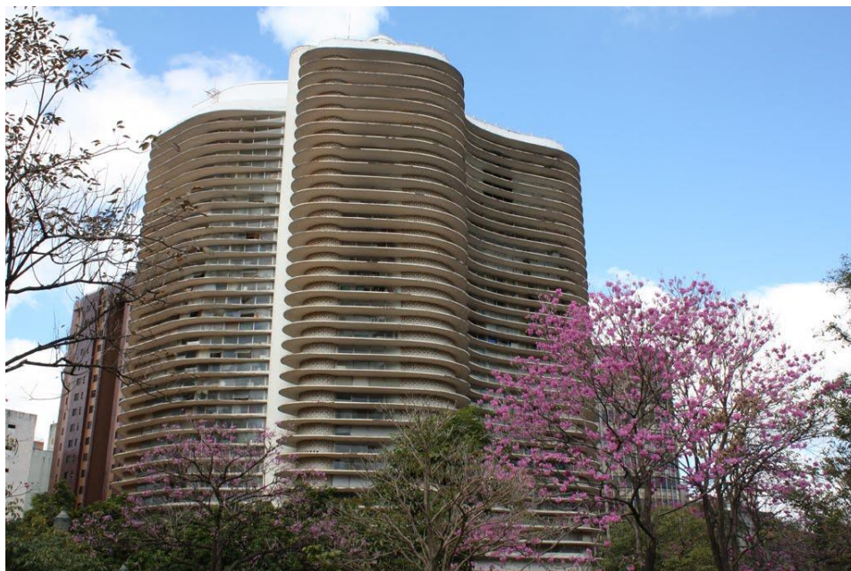
Figura 1- Edifício Niemeyer, Belo Horizonte. (Fonte: redescobrimto.com.br/ )
