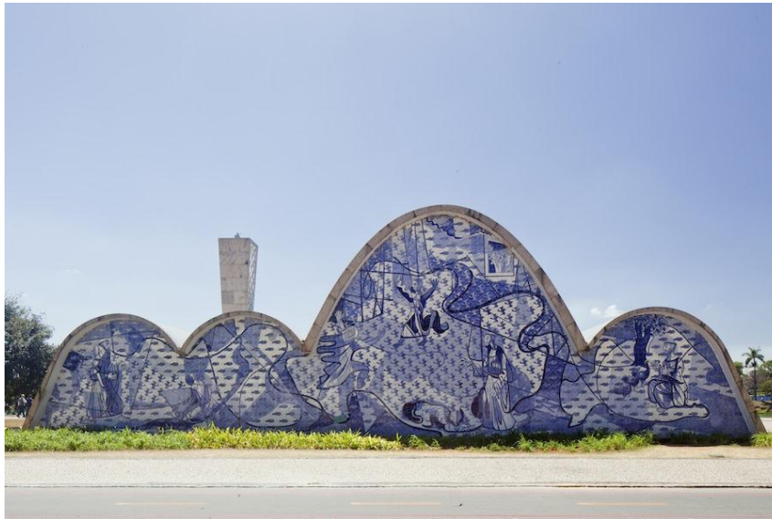
Figura 1.2: Igreja São Francisco de Assis na Pampulha, Belo Horizonte-MG
