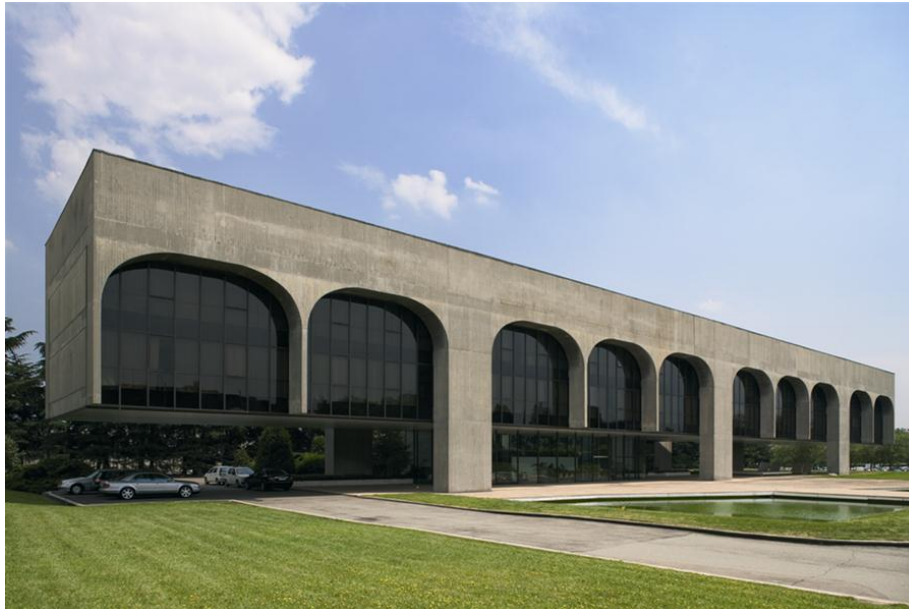
Figura 1.6: Sede da empresa Fata Engineering em Turim, Itália.
