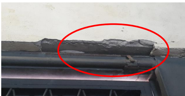
Figura 11: Desplacamento
