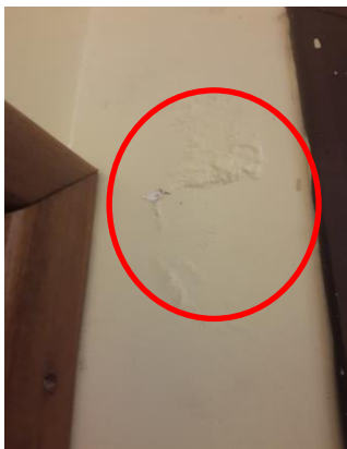
Figura 08: descolamento com empolamento.
