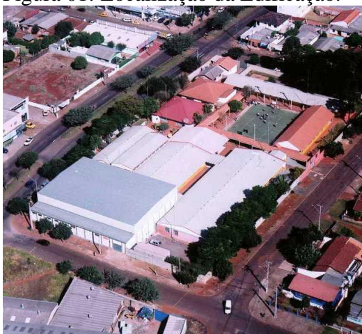
Figura 01: Localização da Edificação.
