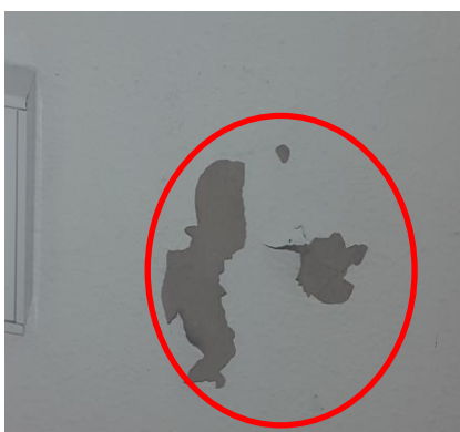
Figura 12: descascamento
