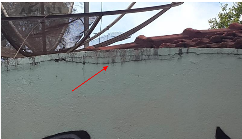
Figura 14: fissura horizontal.
