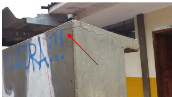
Figura 04: fissura horizontal.
