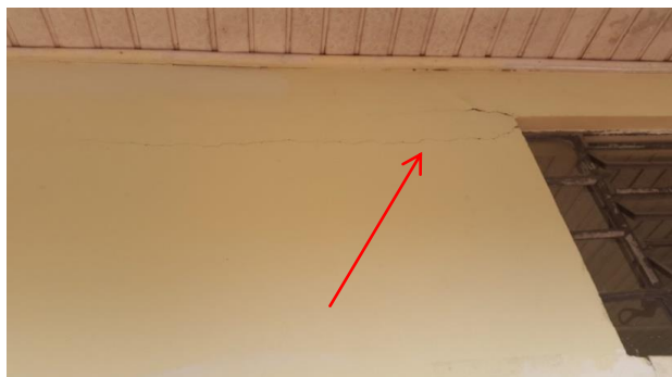
Figura 02: trinca horizontal.
