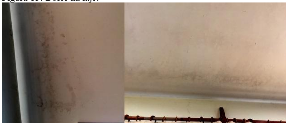
Figura 13: Bolor na laje.
