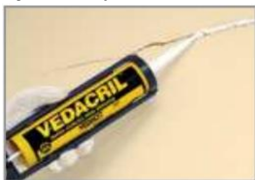
Figura 7: Correção de fissuras com mástique de acrílico Vedacril.
