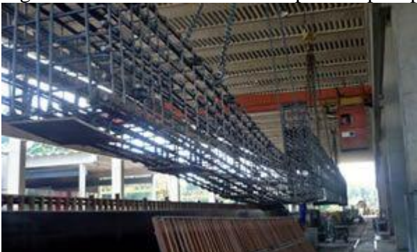
Figura 3 – Armadura sendo transportada pela ponte rolante
