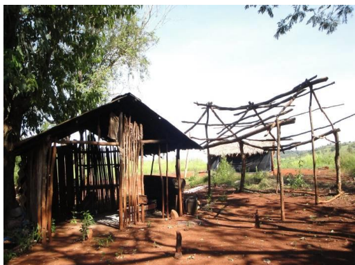
Imagem contendo duas construções, uma delas apresenta a parte estrutural e a segunda contém a cobertura e algumas paredes. Aldeia Tekohá Añetete, Município de Diamante do Oeste/PR, em abril 2012, por Gracieli E. Schubert Kühl.
