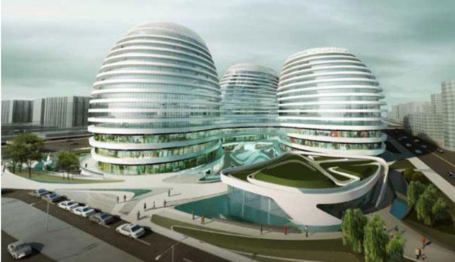
Figura 04– Edifício Galaxy Soho em Pequim.
