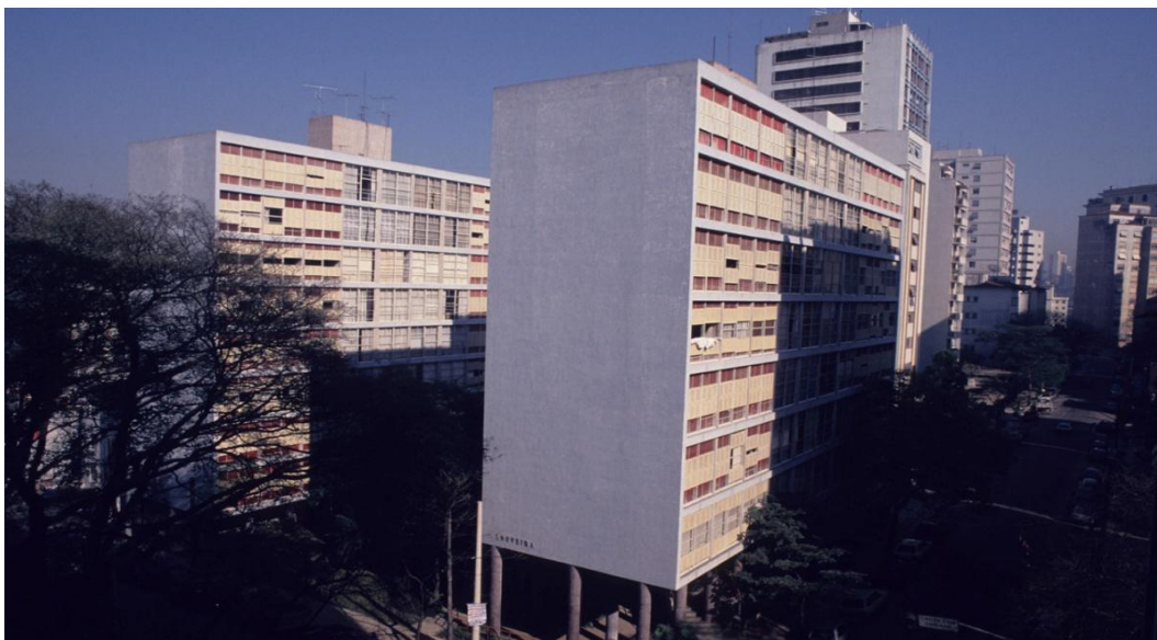
Figura 2 - Edifício Louveira. São Paulo.
