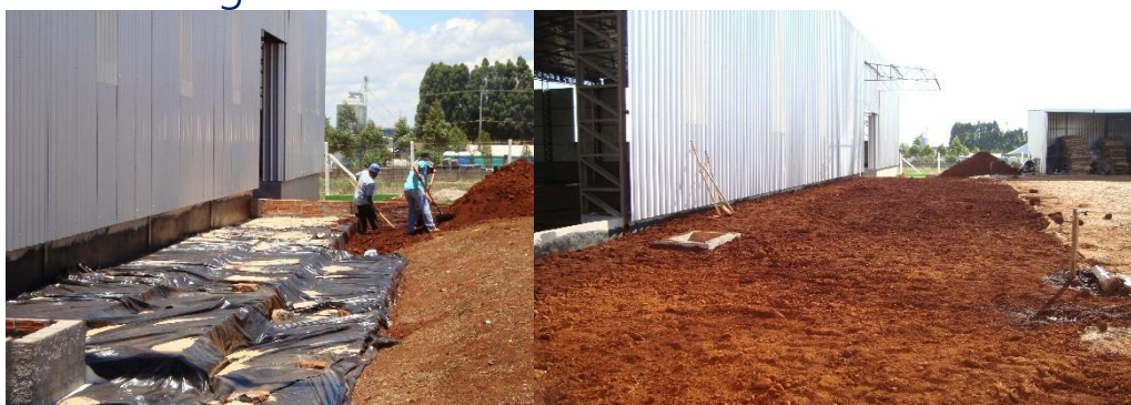
Figura 11- Nivelamento no solo com EPS
