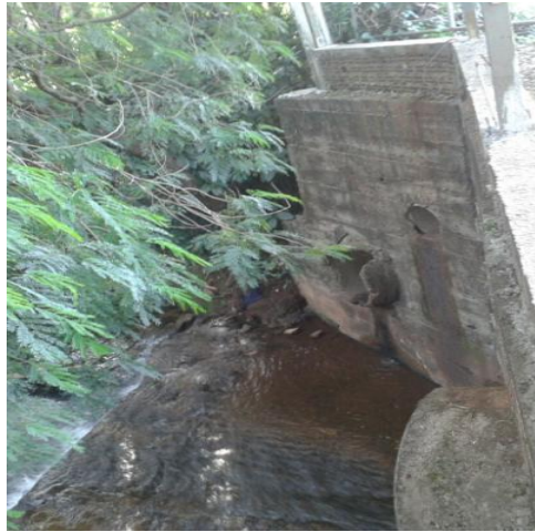
Figura 1. Galeria de águas pluviais.
